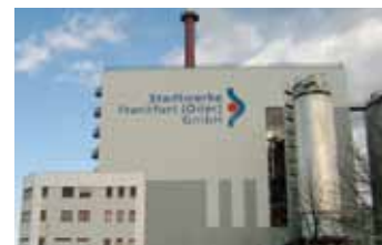
Kraftwerk der Stadtwerke Frankfurt/Oder
