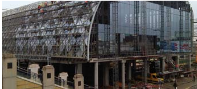
Baustelle Bahnhof Posen
