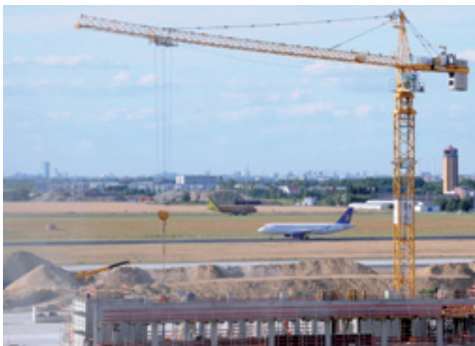
Baustelle am Großflughafen Berlin-Brandenburg International (BBI)
