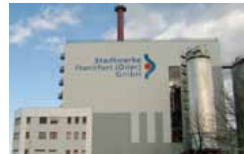
Kraftwerk der Stadtwerke Frankfurt/Oder
