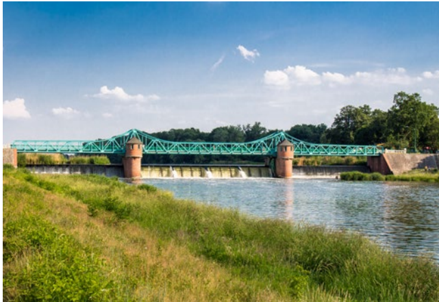
Die Oder hat viele Gesichter: Hier ist das Stauwehr Bartheln in Breslau zu sehen
